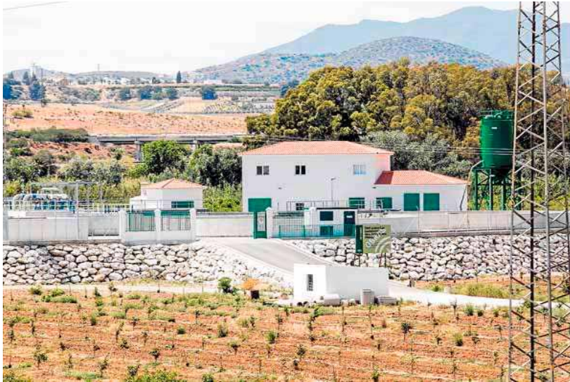
Vista del exterior de la EDAR del Bajo Guadalhorce, con el cartel indicativo de obras de la Junta. SUR
