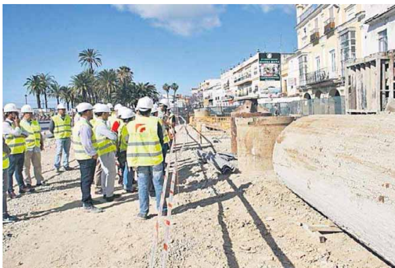
Una imagen de archivo de una visita a las obras del parking de Pozos Dulces, durante el gobierno de PSOE e IU.
