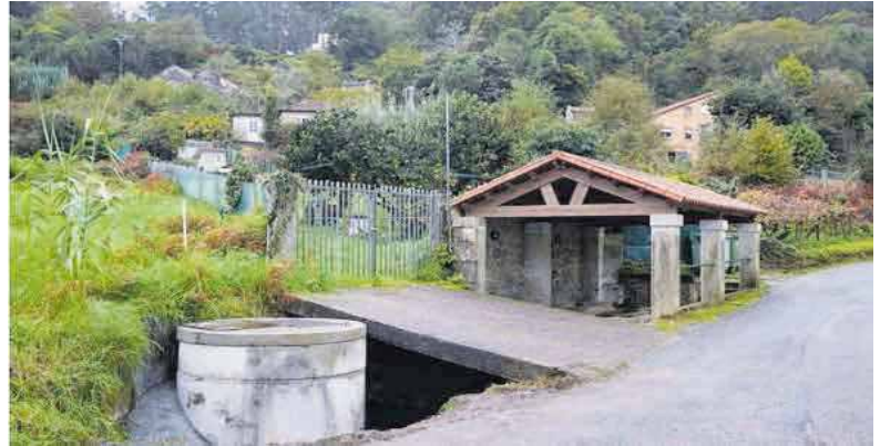
Lavadero de Lubrei, en O Hío, donde se realizaron las obras.
