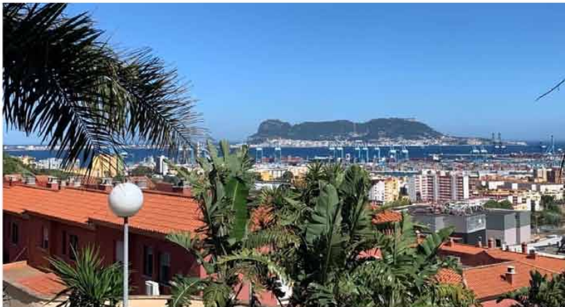
San Bernabé, una de las barriadas afectadas. Mejoras en el Depósito Rosario este jueves afectarán a la presión del agua en varias barriadas.
